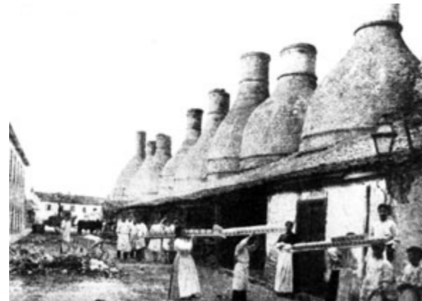
J. Peinado. Cargando tazas y obra cruda en los hornos de botella de la fábrica La Asturiana , ca. 1920 Arte e industria en Gijón (1844-1912). La fábrica de vidrios de Cifuentes, Pola y C. Emilio Marcos Vallauré. Museo de Bellas Artes de Asturias, Gijón, 1991, pág. 270
