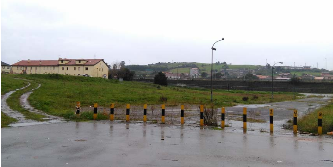
Vista de la Parcela APR S-11(Sur) desde el Apeadero de Llaranes (Norte)
