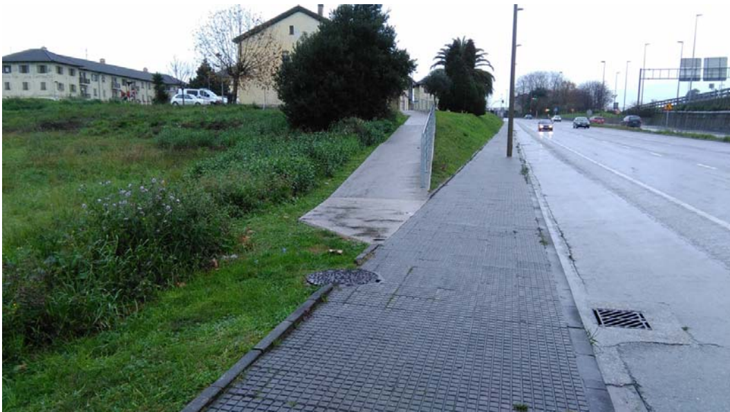
Foto 10: acceso peatonal al Poblado de Garajes de reciente construcción. Sin interés
