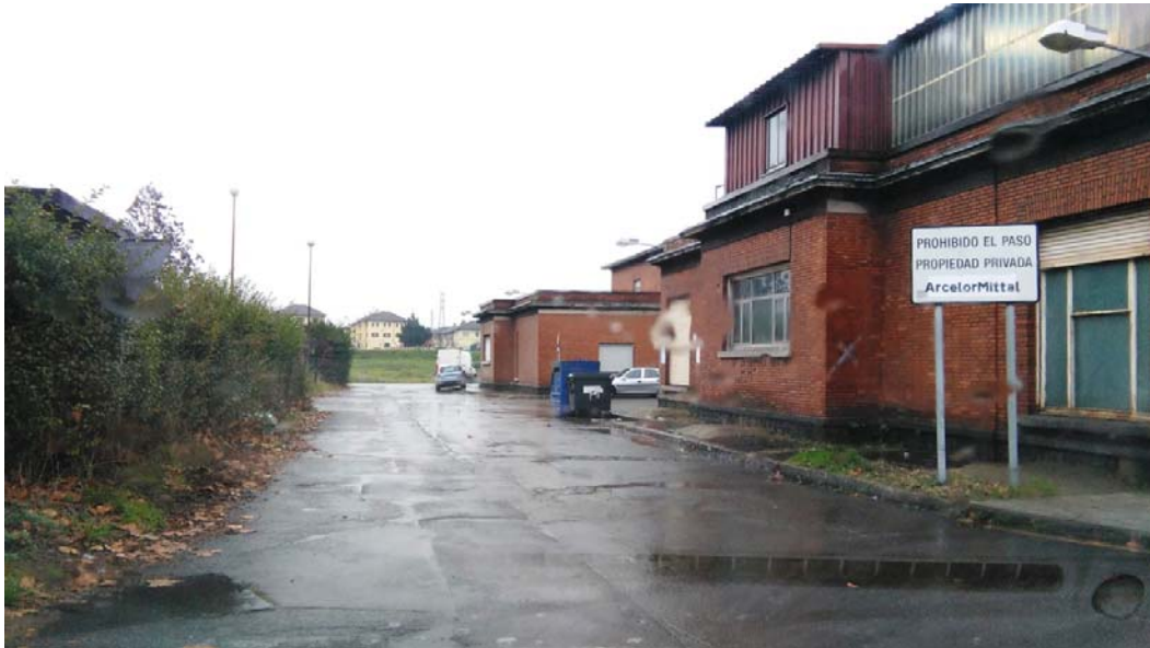
FOTO 3: lateral del Hospital, sin elementos destacables
