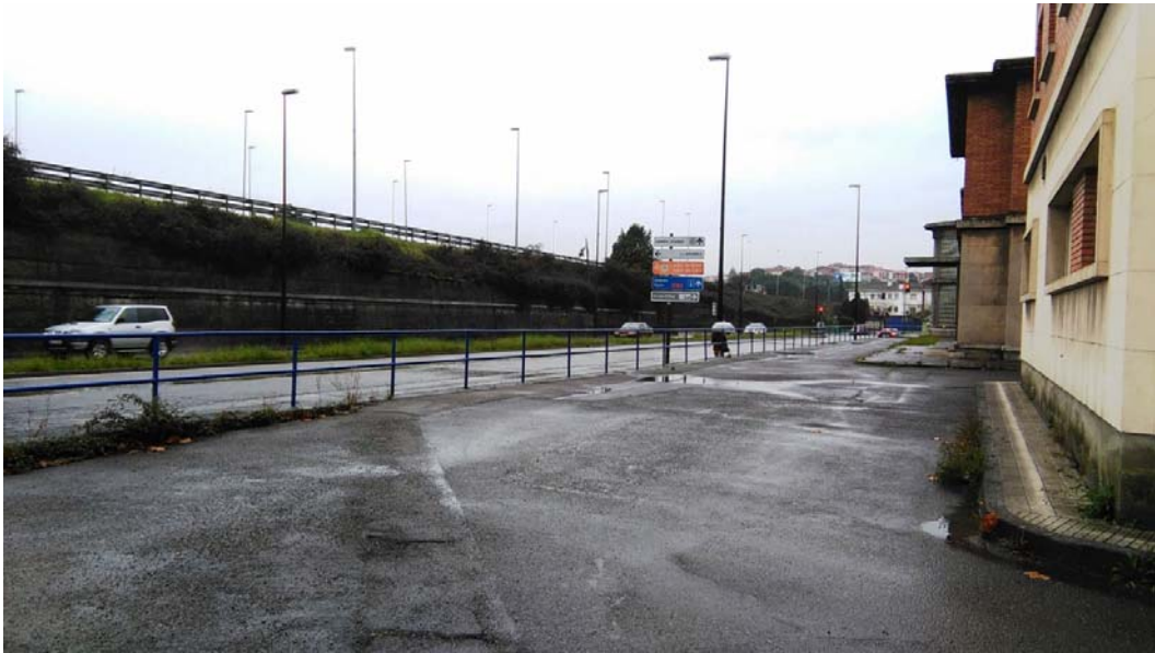
FOTO 9: detalle barandilla contra AS-19, sin interés
