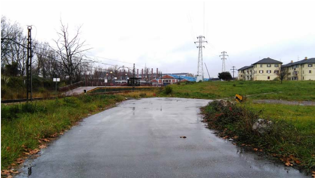
FOTO 5: Vista del apeadero, bolardos por el otro extremo del acceso. Sin nada reseñable
