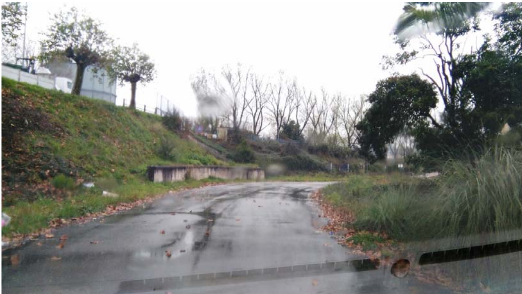
FOTO 4: curva de la urbanización interior hacia el apeadero. Nada reseñable
