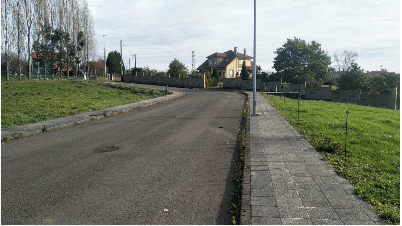
Vial ejecutado sobre el que se ejecutarán modificaciones.
