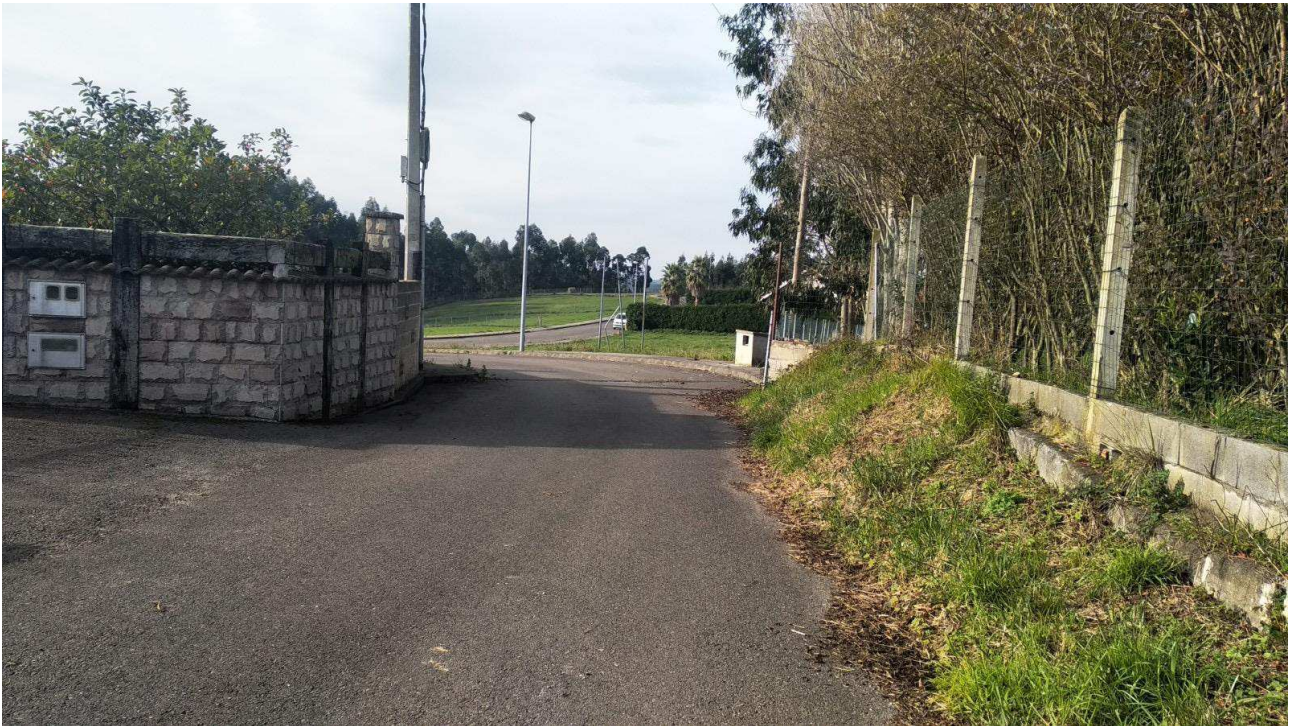
Encuentro de la zona a desarrollar con vial ejecutado.
