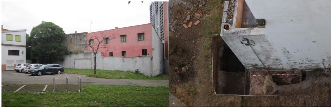
Foto 13. Tramo 2 de la muralla
