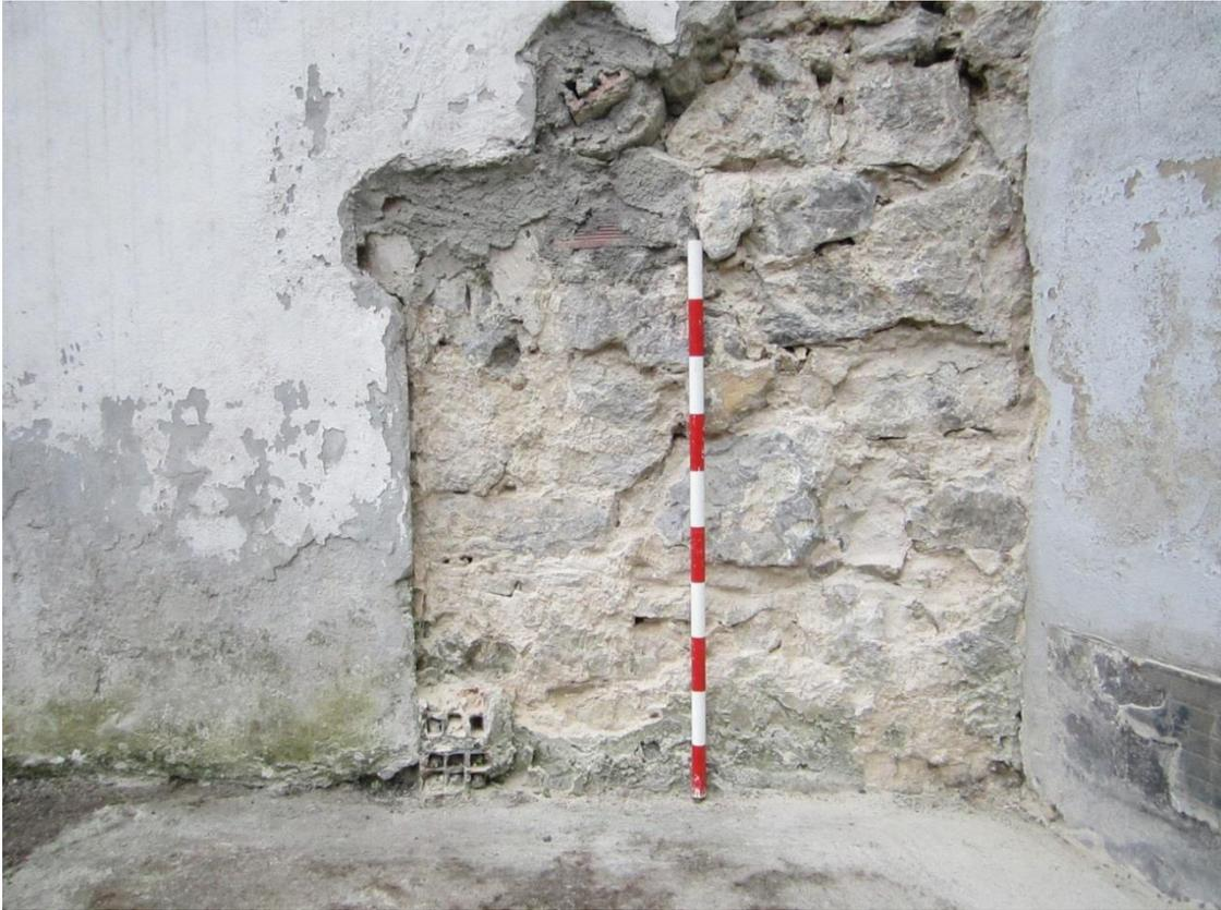
En el tramo documentado del paramento se advierten numerosos cortes y refacciones de época contemporánea, con la inclusión de tubos de hormigón, ladrillos y revocos de cemento.
