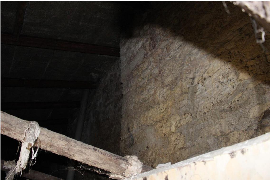
Documentación del paramento exterior de muralla a través del falso techo de la vivienda situada en el nº 42. Se aprecia el tramo superior de la muralla, con fábrica de mampostería ordinaria de piedra caliza parcialmente recubierta con revocos de argamasa.
