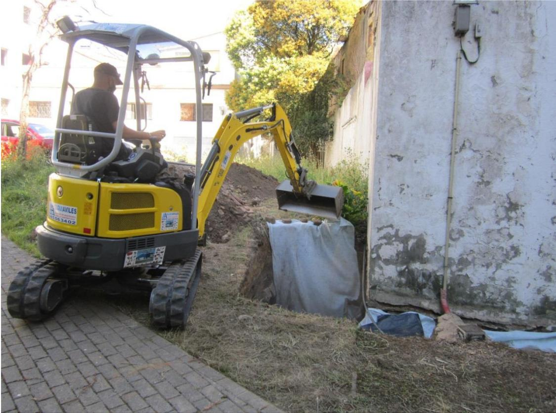
Trabajos de relleno del sondeo 3 con la tierra de la escombrera una vez colocado el geotextil y el plástico
