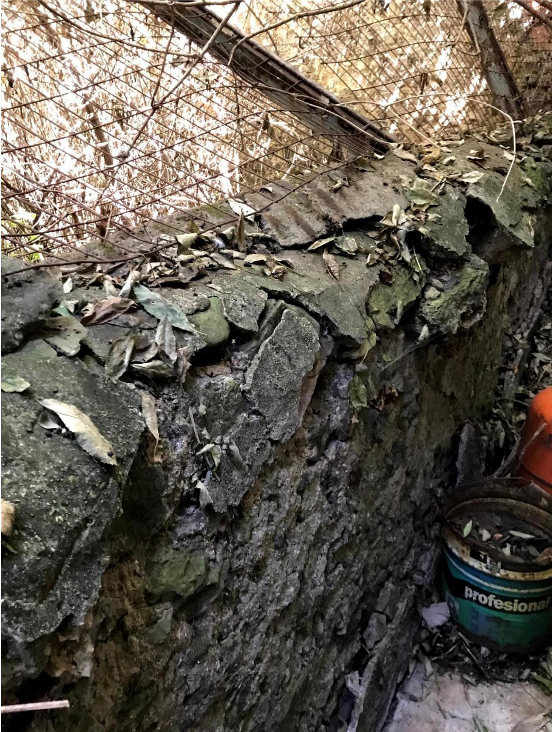
Detalle de las fracturas, desprendimientos y pérdida de material que presenta el remate albardillado del parapeto interior a la altura del nº 2 de la calle de El Muelle.
