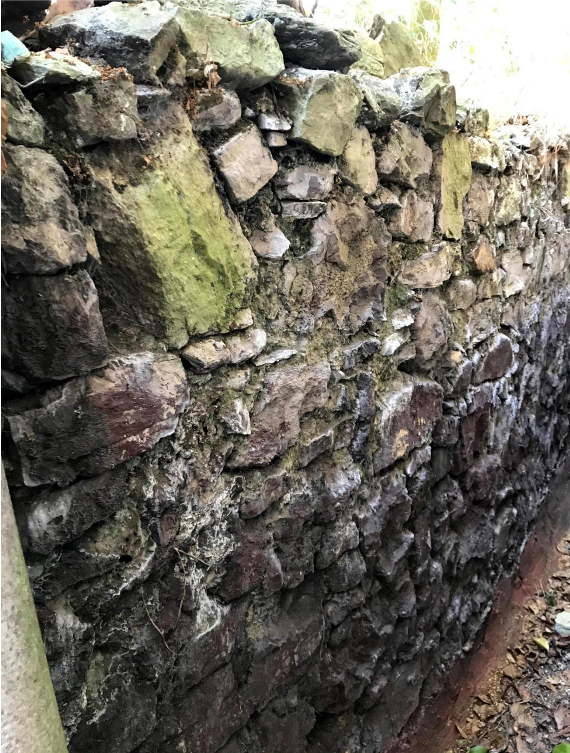
Detalle de uno de los tres posibles vanos localizados en las hiladas superiores del parapeto interior del adarve. Estos vanos se encuentran delimitados por grandes bloques de piedra caliza beige, que se dispone en oblicuo con respecto a las hiladas horizontales generales que presenta el muro del parapeto.
