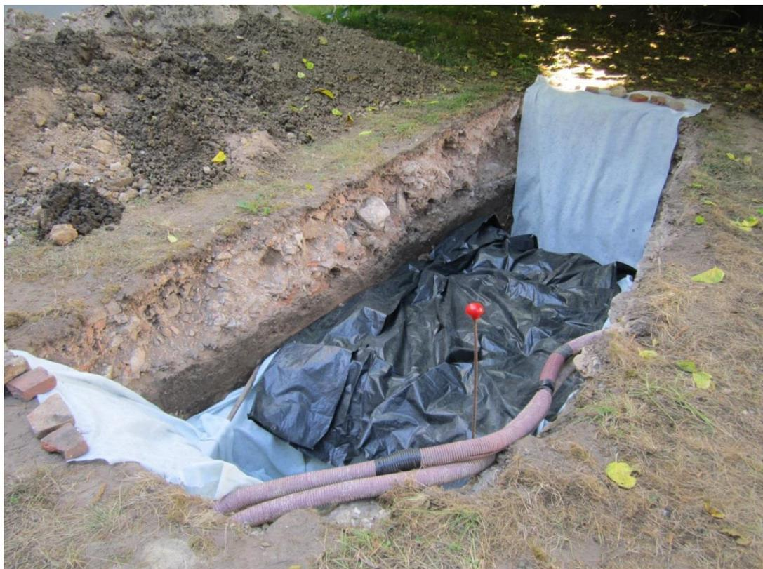
Disposición de láminas de geotextil y de capas de plástico galga en el sondeo 3
