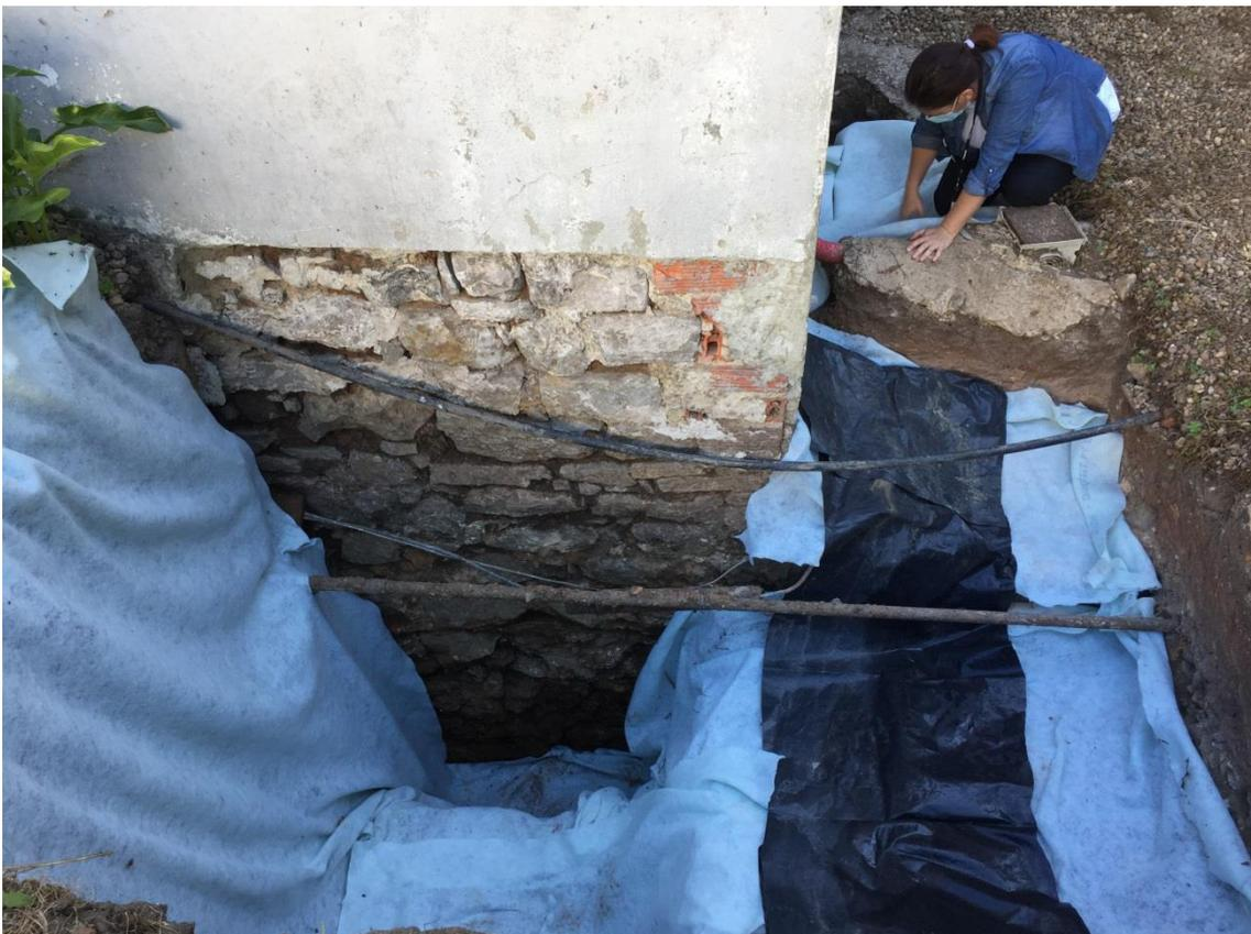
Trabajos de colocación de láminas de geotextil y de plástico negro galga en el sondeo 2
