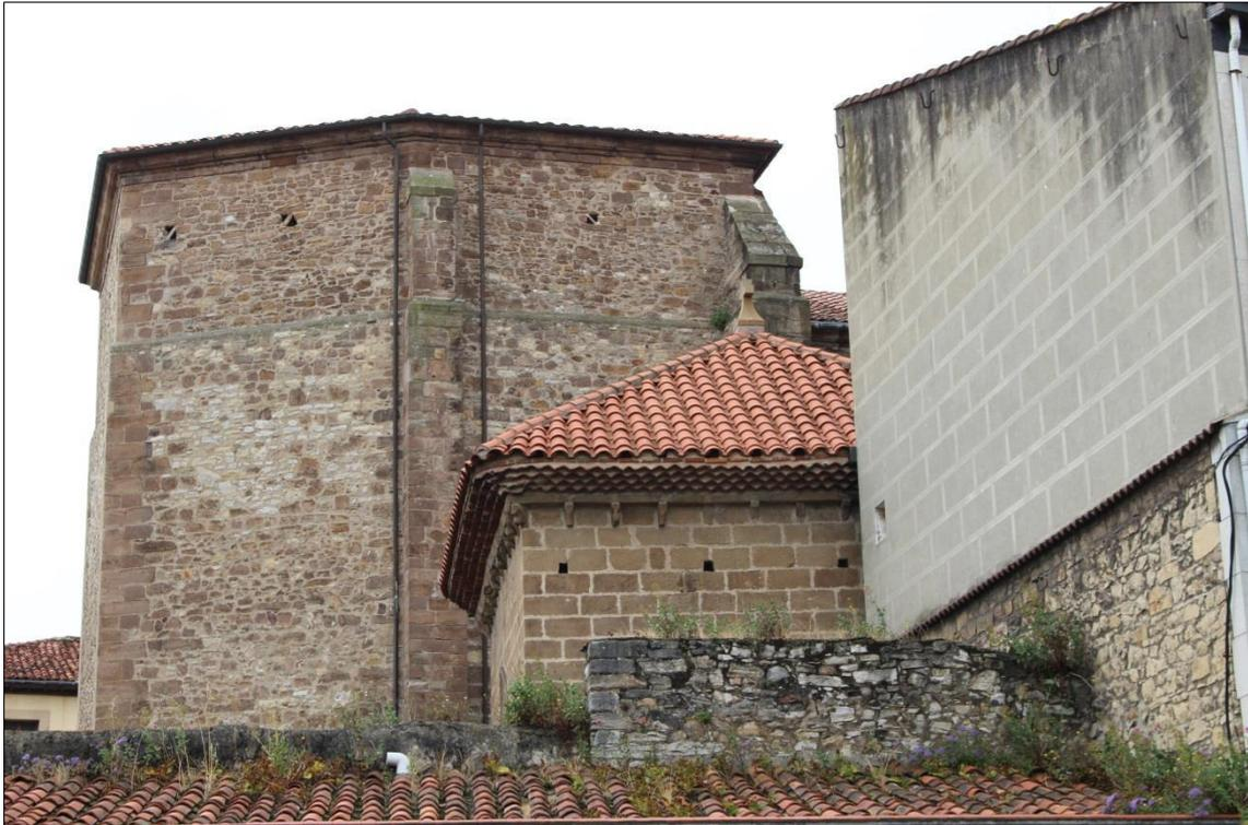
Detalle de las estructuras murarias que sobresalen por encima de la línea del tejado y que se superponen al paramento exterior de la muralla. El tramo más occidental presenta una esquina en sillarejo con un retranqueo de unos 30-40 cm.
