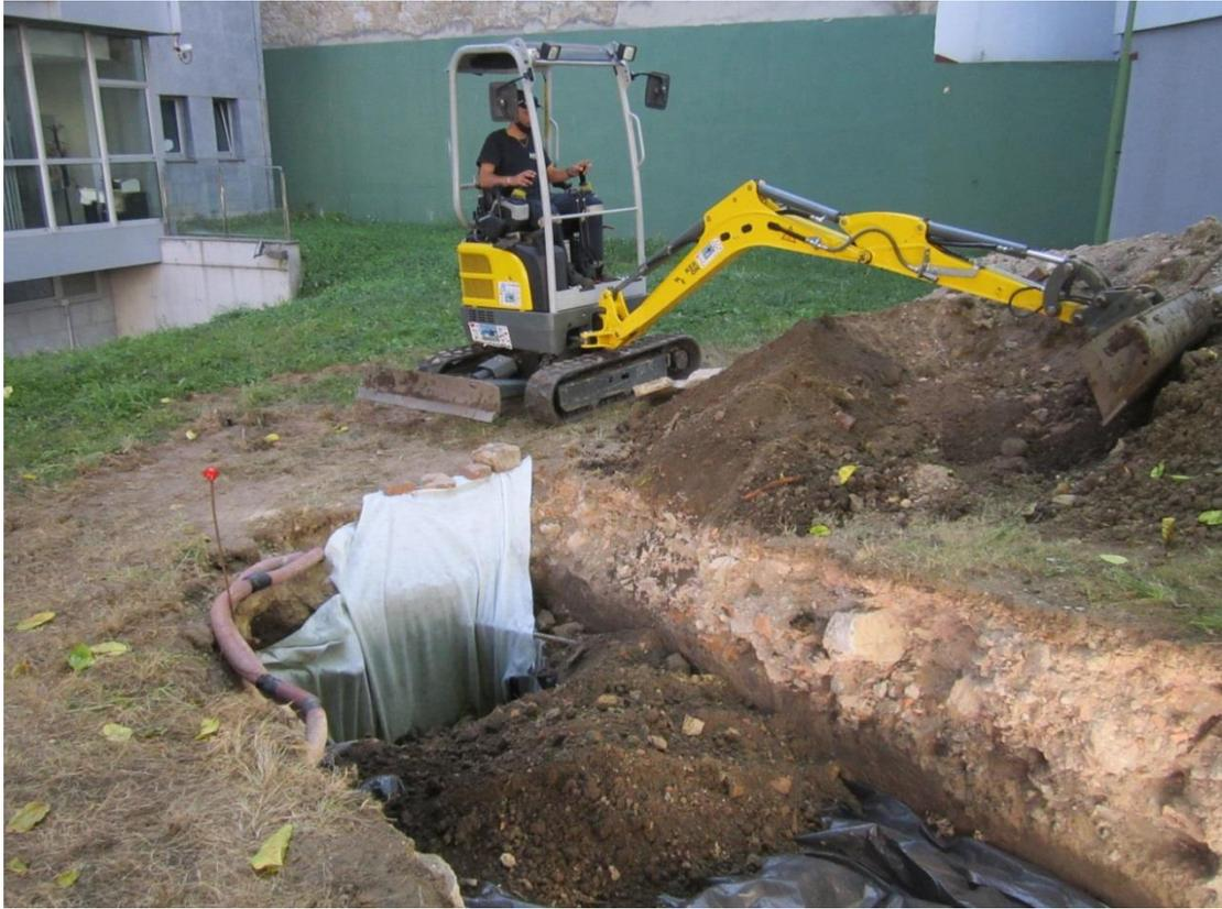
Trabajos de relleno del sondeo 3 con la tierra procedente de la escombrera de la excavación
