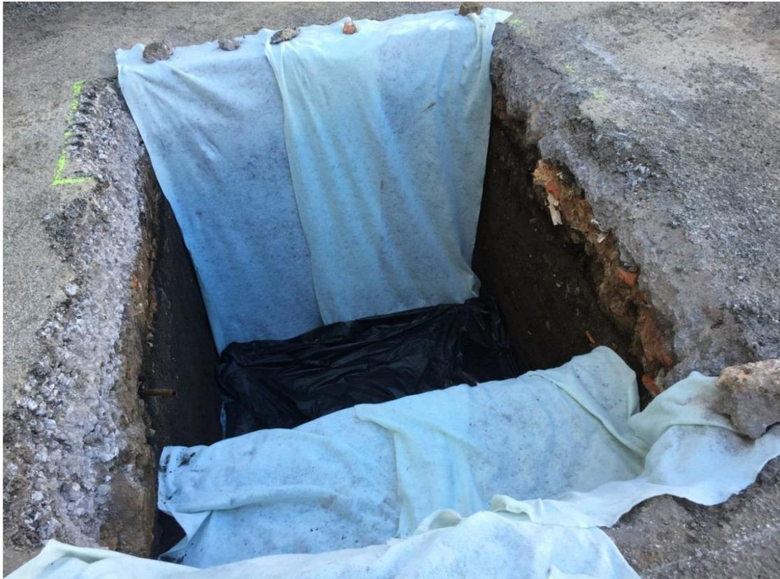
Proceso de colocación de láminas de geotextil y de plástico galga en el sondeo 4
