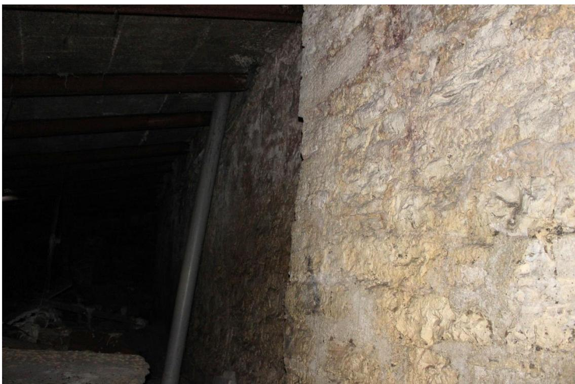
En este tramo el paramento exterior de la muralla presenta una esquina con un retranqueo de 40 cm. Desconocemos por el momento si este retranqueo se corresponde con la huella de un antiguo contrafuerte, estribo o torre de la muralla.
