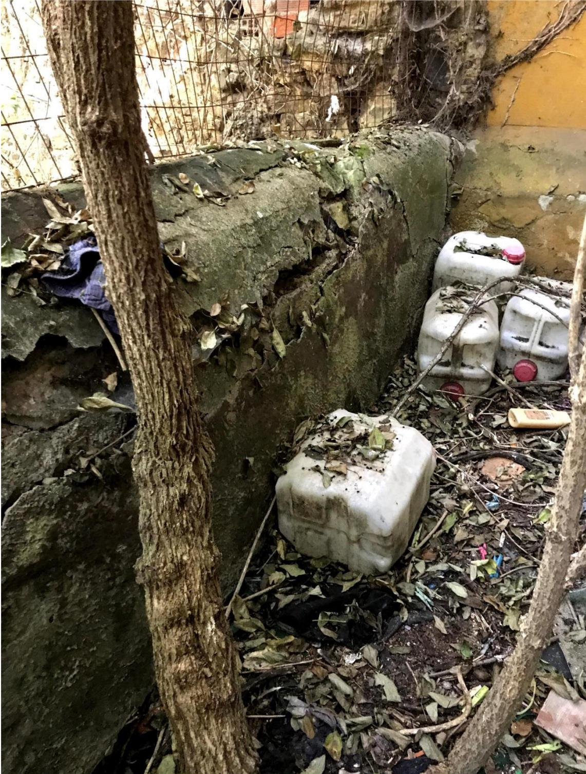
Vista del parapeto interior a la altura del nº 2 de la calle del Muelle. El remate superior del parapeto se encuentra intensamente afectado por la instalación de una verja metálica en el siglo XX
