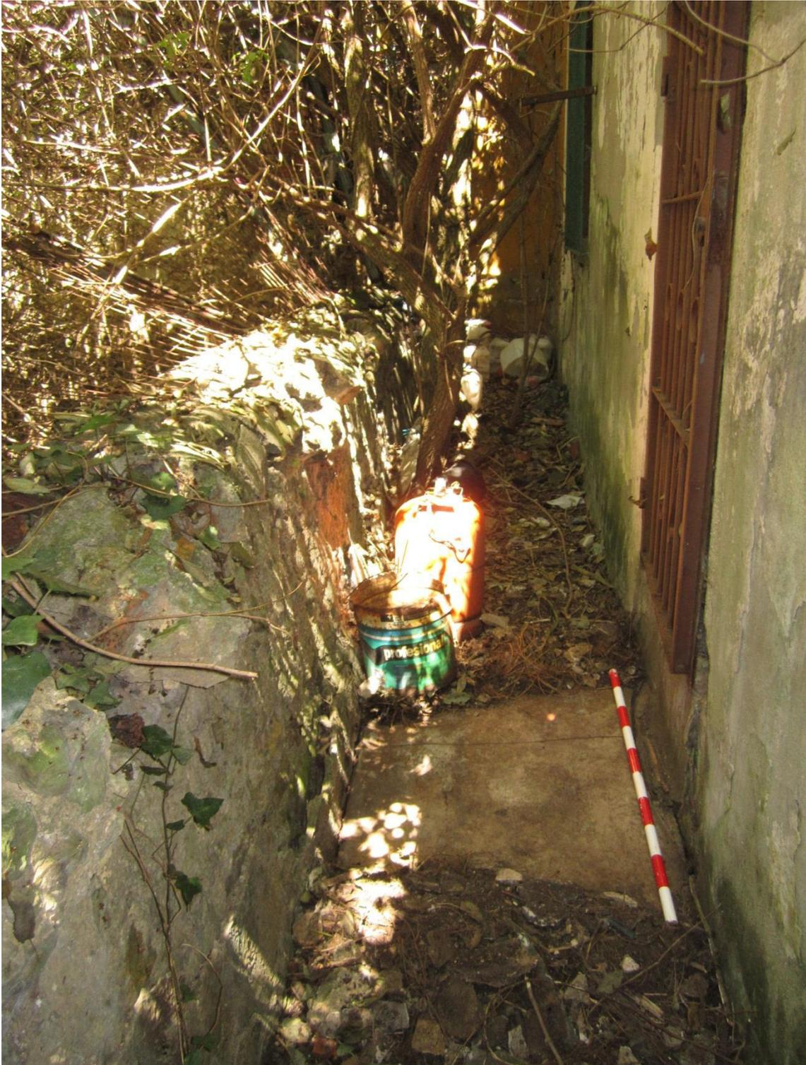
Vista del paso de ronda y del parapeto interior del adarve de la muralla, al que se adosa la fachada trasera del nº 2 de la calle de El Muelle. El paso de ronda presenta una anchura de 83,5 cm (una vara de Burgos) y el parapeto interior conserva una altura media de 105-110 cm.
