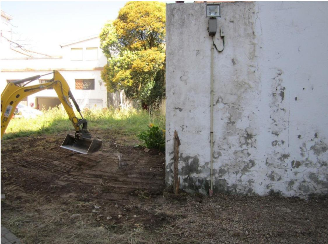
Rellenado final y aplanado del sondeo 2 con la tierra de la escombrera generada por la excavación
