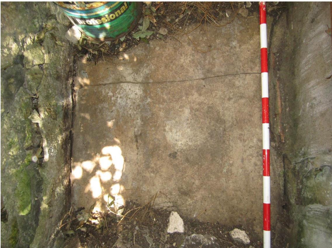
Superficie del pavimento del paso de ronda del adarve. Hasta que no se realicen los análisis pertinentes no se podrá definir si puede tratarse de un pavimento original del siglo XVIII o si por el contrario se corresponde con una reforma del siglo XX que incluya cemento portland.
