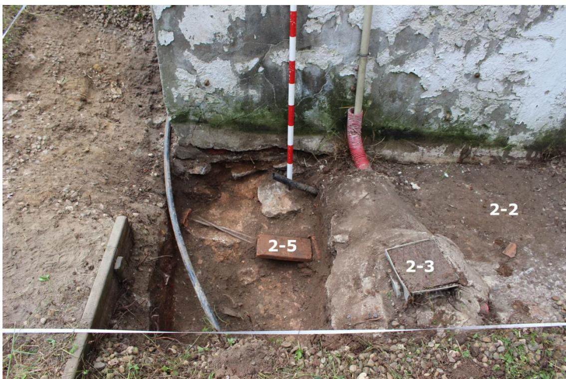
Sondeo 2. UE 2-5: cubierta de ladrillo perforado que sirve de aislamiento a cableado de líneas eléctricas
