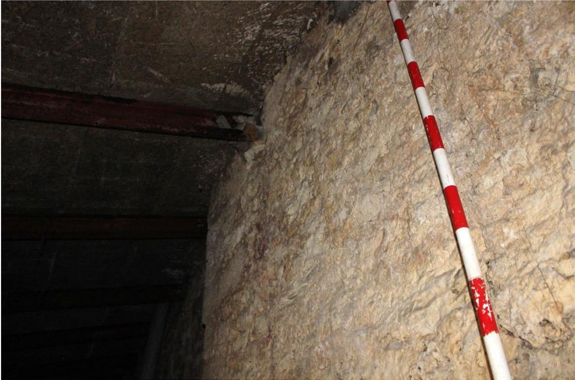
Vista del tramo superior de la muralla documentada. Se aprecian las vigas metálicas de doble T que se encastran en la muralla y que soportan las claves de virutex.
