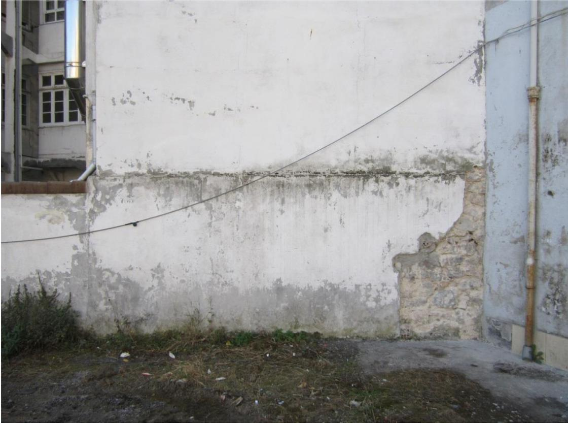
Vista frontal del tramo inferior de la fachada trasera del edificio nº 23, en la que se aprecia el posible paramento interior de la muralla, en mampostería de piedra caliza.
