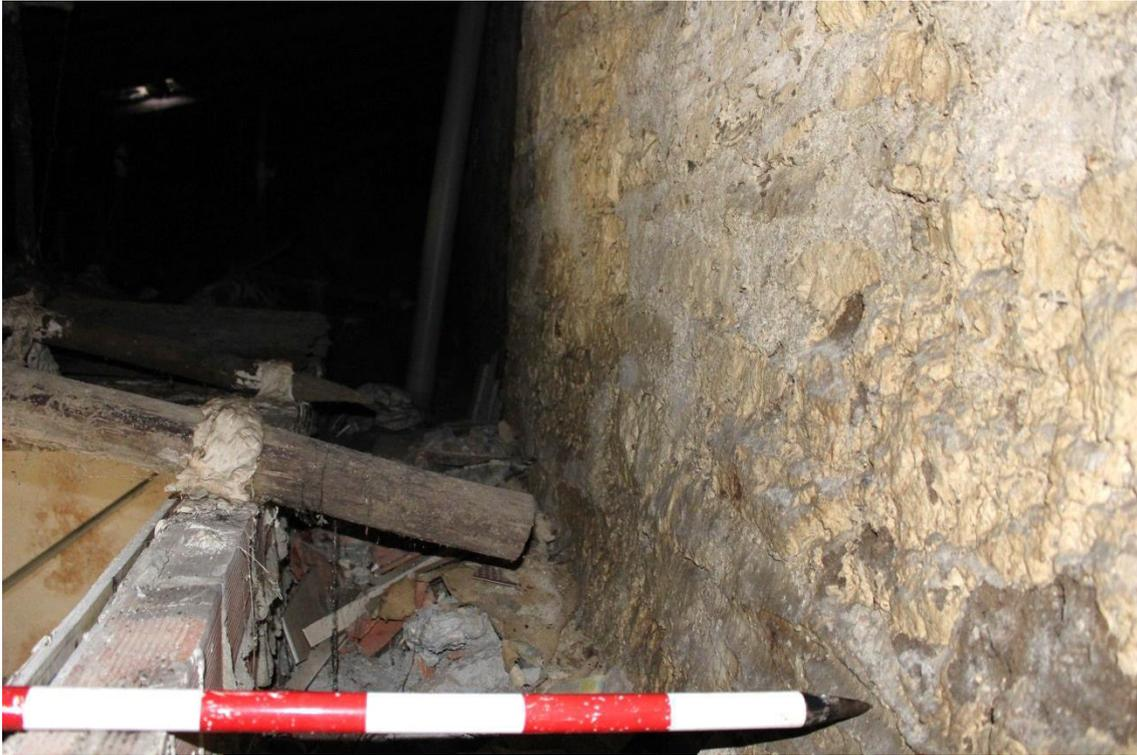
Detalle del tabique trasdosado que oculta el tramo inferior de muralla documentado. Este tabique de ladrillo perforado presenta 2,8 m de altura y unos 10 cm de grosor. Entre el tabique y la cara externa de la muralla se encuentra un hueco de unos 40 cm de profundidad y que se encuentra relleno de escombros.
