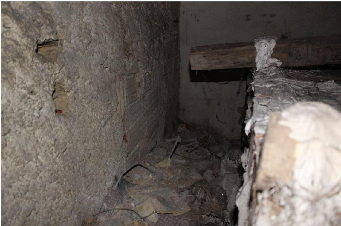
Vista del extremo occidental del tramo de muralla documentado. Se aprecia el tabique trasdosado de ladrillo que oculta el paramento de la muralla y que soporta el falso techo. En el paramento de la muralla se aprecia una perforación tapada con ladrillo.
