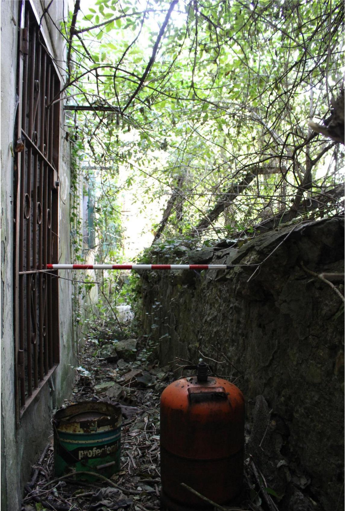
Vista del paso de ronda y del parapeto interior del adarve de la muralla, al que se adosaron las fachadas traseras de los nº 2 y 4 de la calle de El Muelle.
