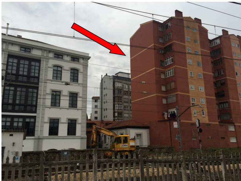
Vista de la medianera del edificio de viviendas
